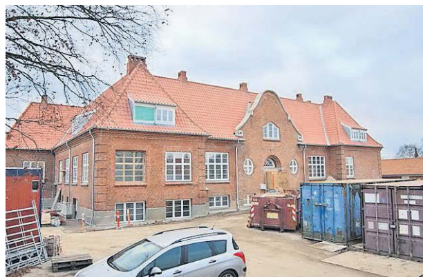
STU-uddannelsen har til huse på Hans Egede Vej i Stubbekøbing. Her har de købt byens tidligere hospital, som de har renoveret og indrettet.
